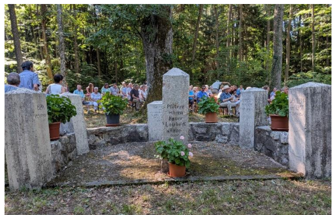
Im Kalenderjahr 2030 feiert das „Augustanadenkmal“ in Matzmansdorf sein 200-jähriges Bestehen. Auch aus diesem Grund werden derzeit vorhandene Schadstellen von einer Fachfirma repariert. Eigentümerin ist die Gemeinde Langfurth. Foto: Simon Schäffler
