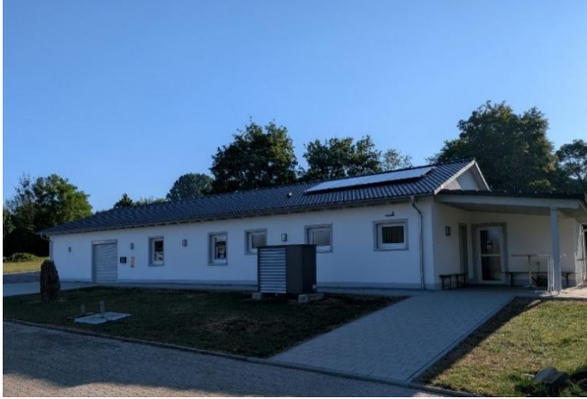
Ende Juni 2026 wurde das neue Ammelbrucher Sportheim offiziell eingeweiht. An der Realisierung des Projektes waren zahlreiche ehrenamtlich Engagierte beteiligt. Foto: Simon Schäffler
