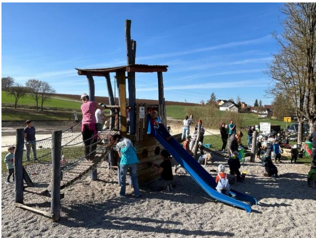
Zahlreiche fleißige Hände sorgten Mitte April 2025 gemeinsam dafür, dass der kommunale Spielplatz in Ammelbruch eine dringend notwendige Sanierung erfuhr. Foto: privat
