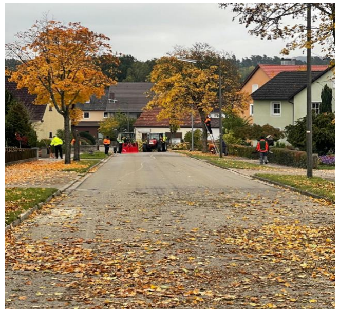
Mitte Oktober 2025 starteten die ersten Vorbereitungsarbeiten für die anstehende Sanierung der „Ammelbrucher Hauptstraße“. Foto: Heinz Kern
